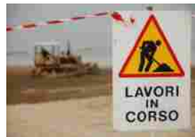
Lavori per la realizzazione della rete in fibra ottica nella zona di via Perennio. Attenzione ai divieti
